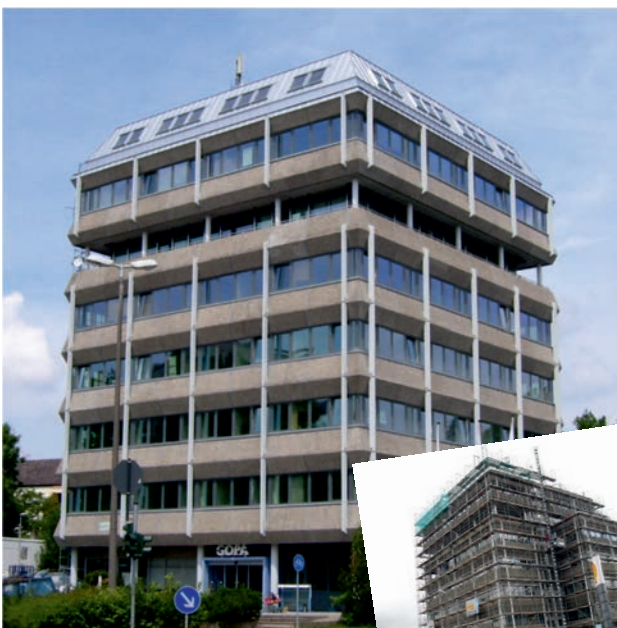
Bürohochhausanierung Bad Homburg
